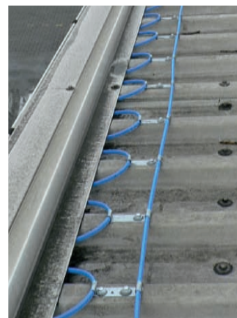
instalace topného kabelu na atypickém okraji střechy
