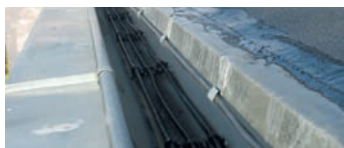
instalace topného kabelu v podokapním žlabu a na hraně střechy (okapnici)
