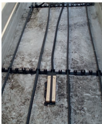
umístění vlhkostního čidla ETOR v hranatém okapovém žlabu
