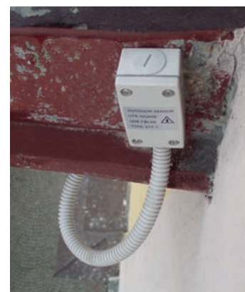
ukázkový instalace teplotního čidla ETF
